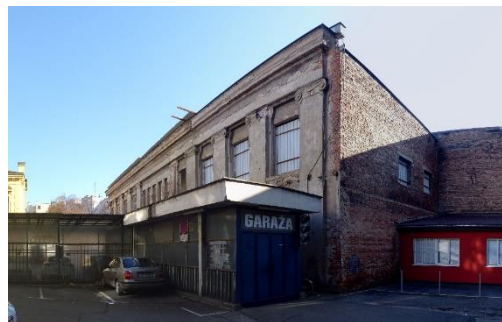
slika 11. sjeverno pročelje Zgrade skladišta
