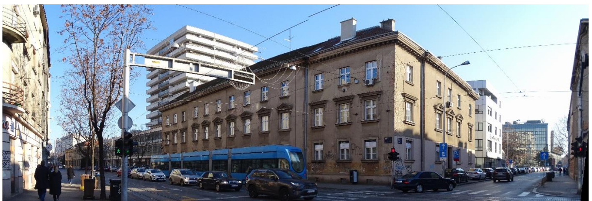
slika 18. pogled s ugla Ulice M. Derenčina i Vlaške ulice na sjeverozapadni pretežito dovršeni dio obuhvata UPU-a (snimljeno 07.12.2021.)
